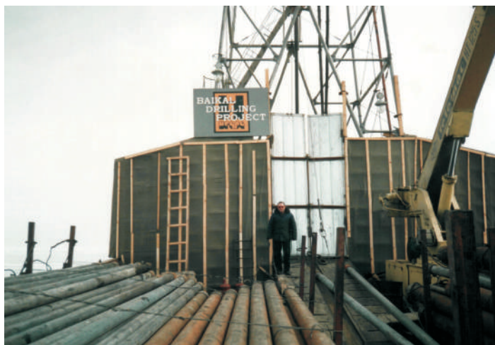
Рис. 5 Размещение бурильных и обсадных труб на приёмных мостках буровой установки
