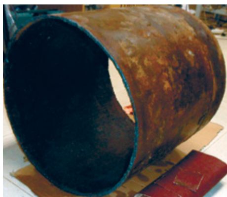
Рис.1. Катушка (фрагмент) аварийного участка конденсатопровода.
